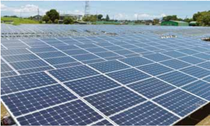
ソーラープラント板東(太陽光発電システム用架台工事)
