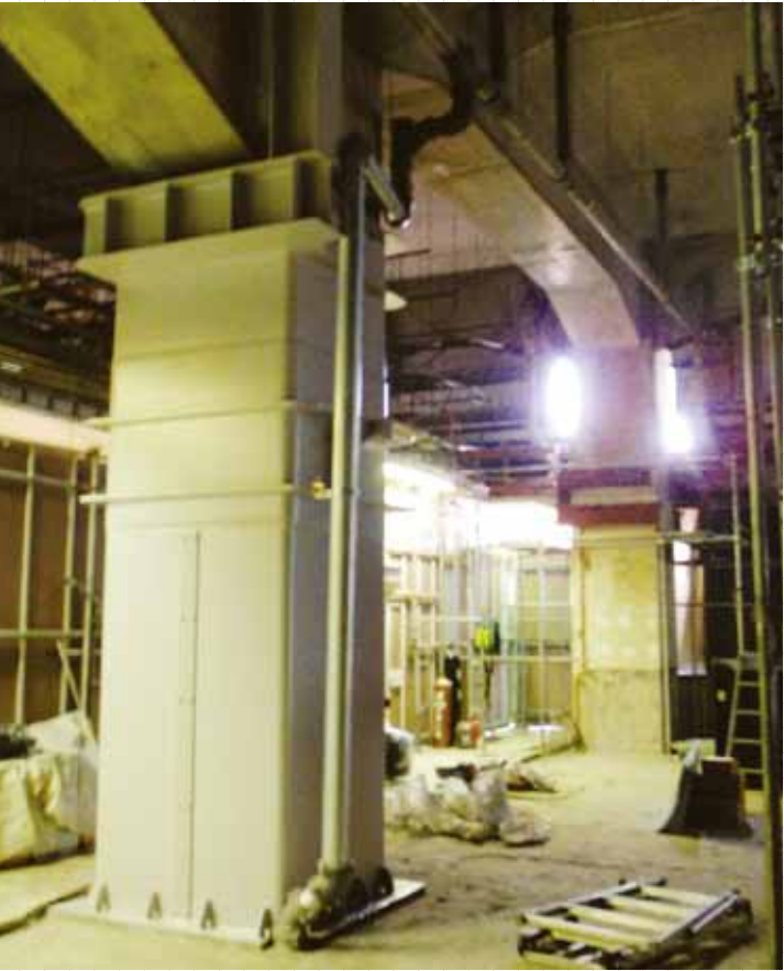
武蔵浦和駅改良工事
