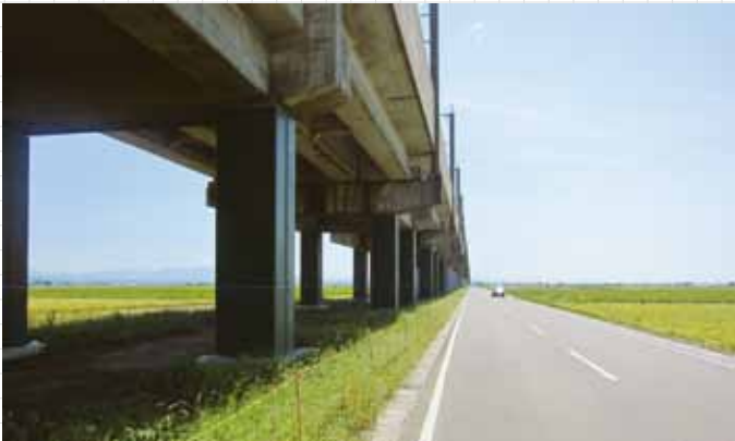
上越新幹線耐震補強工事
