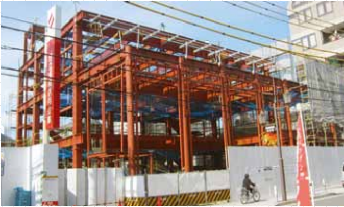
ASC新築工事
