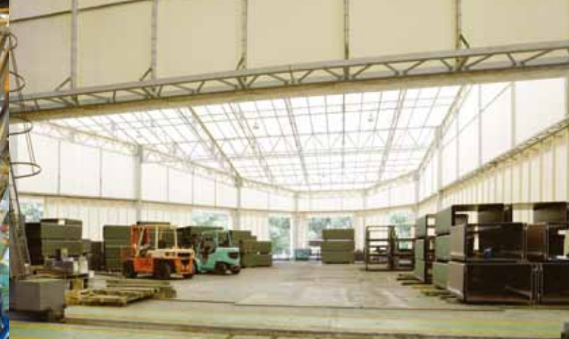
屋内ヤード風景
