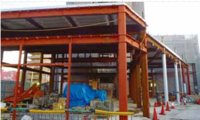
SHDホール棟新築工事
