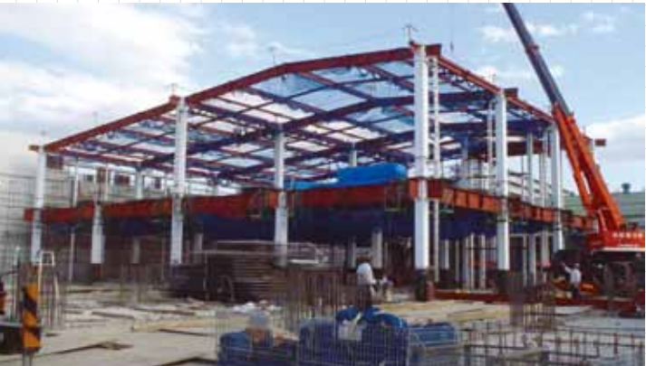
あまだ倉庫新築工事
